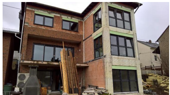
Ansicht nach Sanierung u. Anbau
