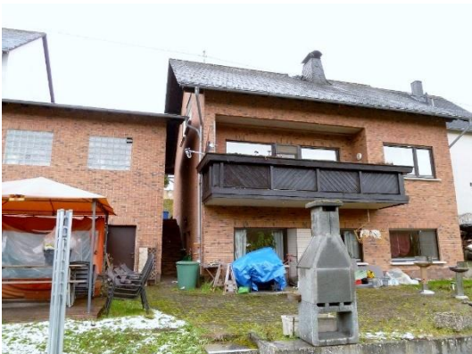
Ansicht vor Sanierung
