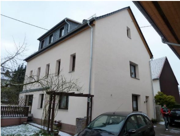
Ansicht Süd-Ostseite nach Sanierung
