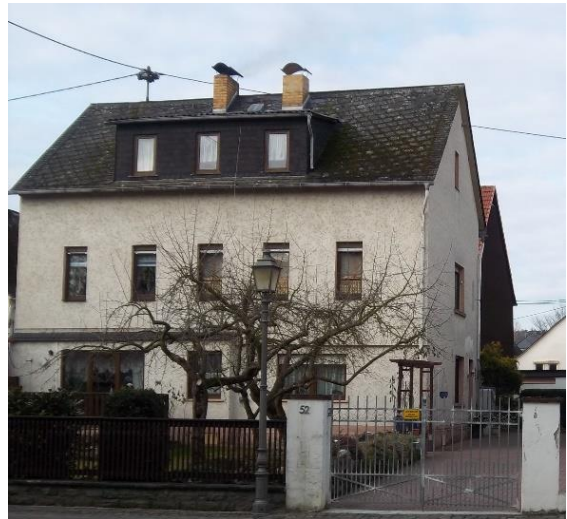
Ansicht Süd-Ostseite vor Sanierung
