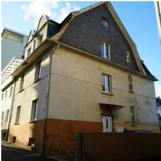
Ansicht Nord-Ostseite vor Sanierung
