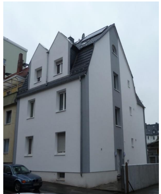
Ansicht Nord-Ostseite nach Sanierung
