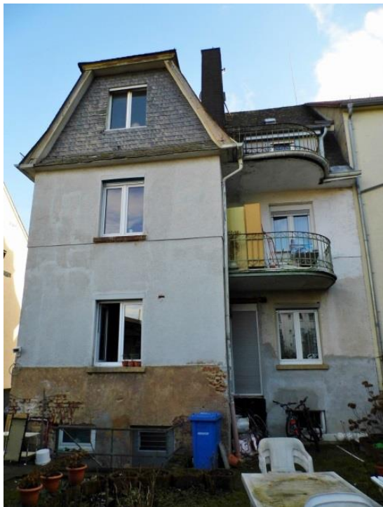
Westseite vor Sanierung
