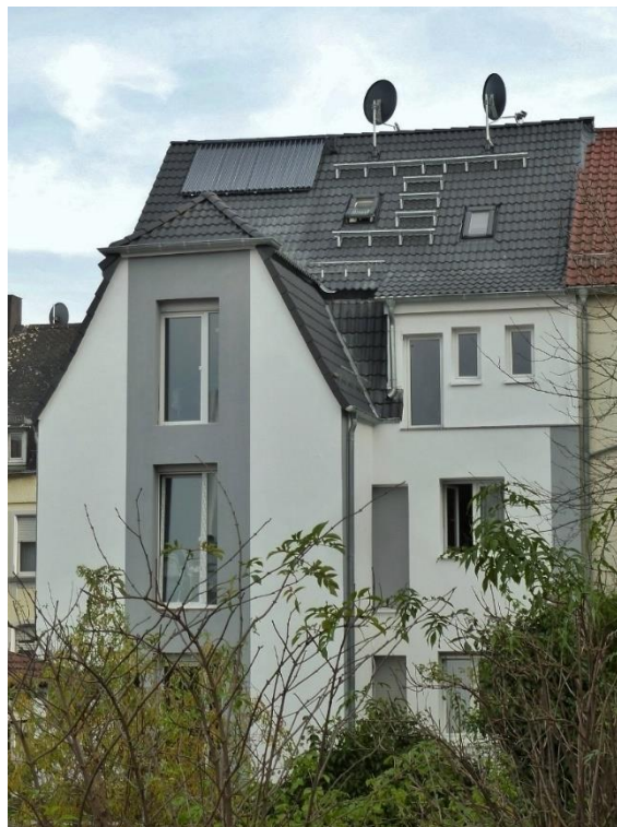
Westseite nach Sanierung
