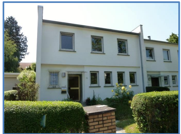
Ansicht Nord-Ostseite vor Sanierung
