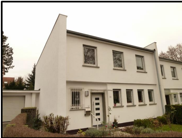
Ansicht Nord-Ostseite nach Sanierung
